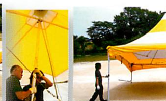
下部足フレームジョ ターンバックルによ 足フレーム垂直、
