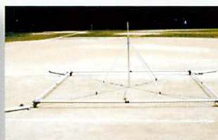
部品を配置し、 各フレームを組み立てる。
