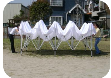
⑤②と同じようにトラスバーの下側を持ち上げながら外側に引張ります。
